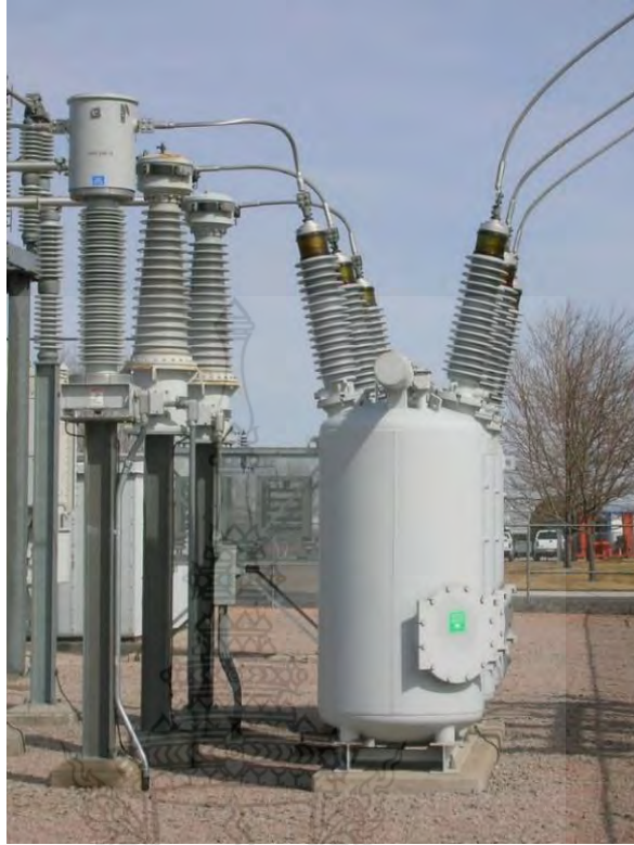
ภาพที่ 0-6 แสดงตัวอย่างเซอร์กิตเบรกเกอร์ที่ใช้ Pneumatic-Operated Mechanism [8]
