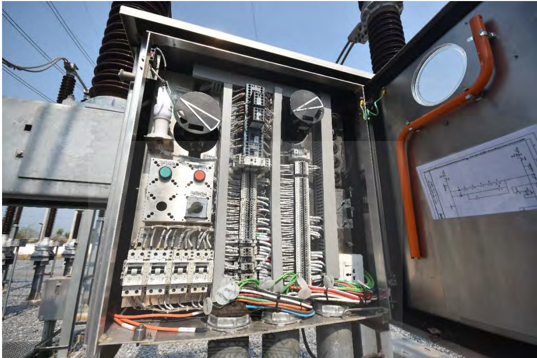
ภาพที่ 0-6 ภาพภายในตู้คอลโทรลเซอร์กิตเบรกเกอร์
