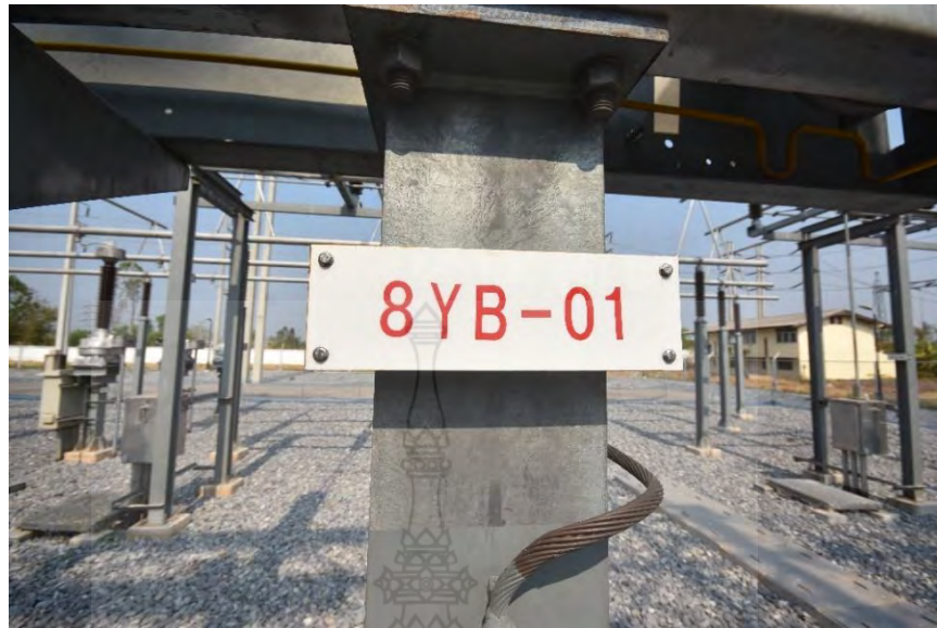
ภาพที่ 0-2 ภาพ Device Code ของอุปกรณ์เซอร์กิตเบรกเกอร์
