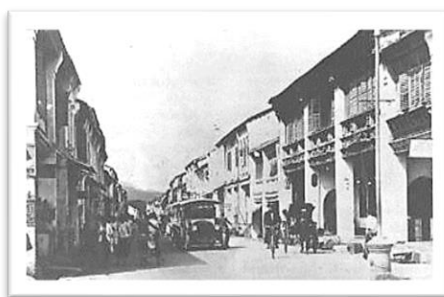
ภาพที่ 2.26 ถนนกลาง ย่านการค้าเก่าใจกลางเมืองภูเก็ตกับอาคารตึกแถว
