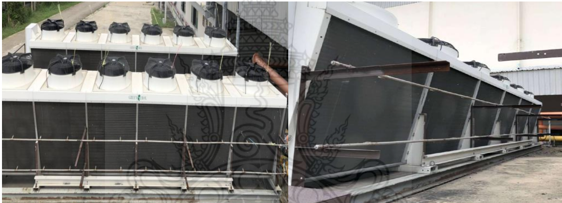
รูปที่ 3.16 การดำเนินการติดตั้งอุปกรณ์ชุดพ่นละอองน้ำ (ภาพจริง)
