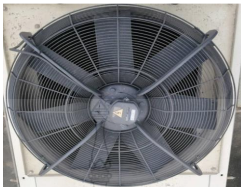
รูปที่ 3.6 มอเตอร์ในหอทำความเย็นระบบปิด
