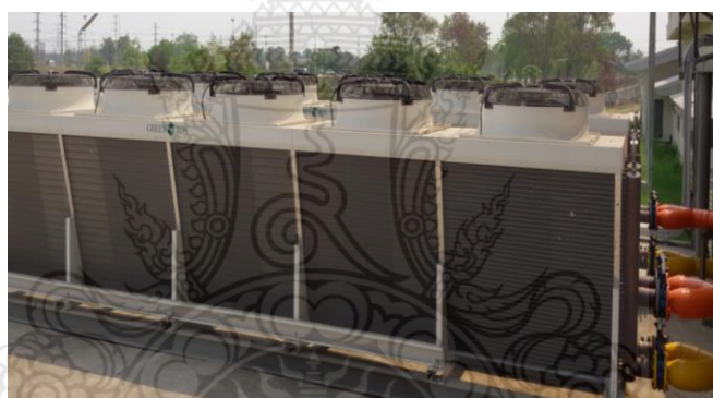
รูปที่ 3.4 หอทำความเย็นระบบปิดแบบระบายความร้อนด้วยอากาศ
