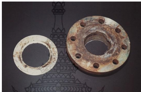
รูปที่ 2.8 การกัดกร่อนแบบ Crevice Corrosion [25]
