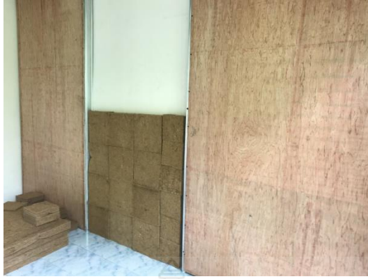
รูปที่ 51 ผนังที่มีการติดตั้งแผ่นป้องกันเสียงและความร้อนจากขุยมะพร้าวและเส้นใยมะพร้าวผสมน้ำยางธรรมชาติภายในก่อนการปิดทับด้วยแผ่นไม้อัด
