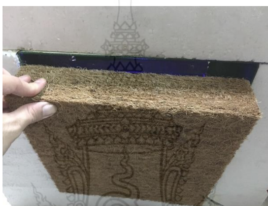
รูปที่ 3.35 การติดตั้งแผ่นป้องกันเสียงและความร้อนจากขุยมะพร้าวผสมน้ำยางธรรมชาติ เพื่อวัดค่าความเข้มเสียง
