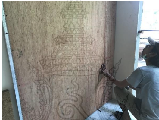
รูปที่ 52 การปิดทับผนังที่ติดตั้งแผ่นป้องกันเสียงและความร้อนจากขุยมะพร้าวและเส้นใยมะพร้าวผสมน้ำยางธรรมชาติด้วยแผ่นไม้อัด
