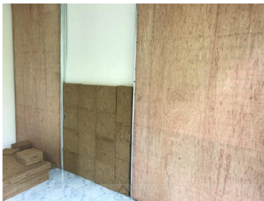
รูปที่ 4.15 ผนังที่มีการติดตั้งแผ่นป้องกันเสียงและความร้อนจากขุยมะพร้าวผสมน้ำยางธรรมชาติภายในก่อนการปิดทับด้วยแผ่นไม้อัด
