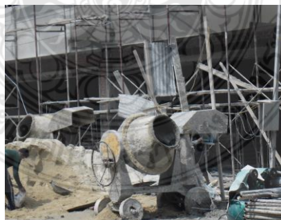
รูปที่ 4.8 พื้นที่ในการกองเก็บวัสดุของโครงการ B
