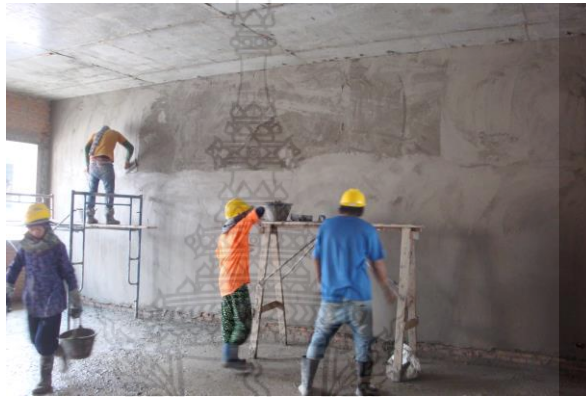
รูปที่ 4.3 พื้นที่ในการทำงานฉาบปูนผนังภายในอาคารของโครงการ A
