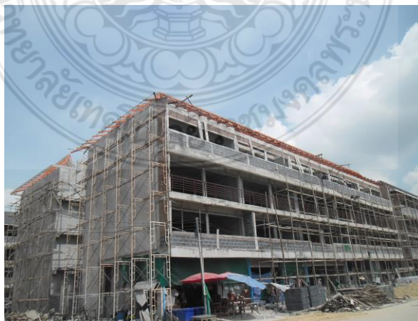
รูปที่ 4.2 สถานที่ก่อสร้างโครงการ B
