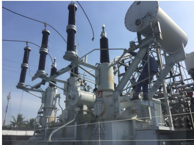
ภาพที่ 3.1 การปลดโหลดของหม้อแปลงไฟฟ้ากำลัง
