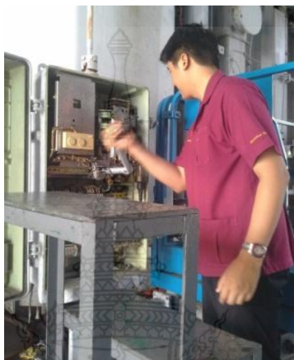
ภาพที่ 2.5 Change of tap transformer
