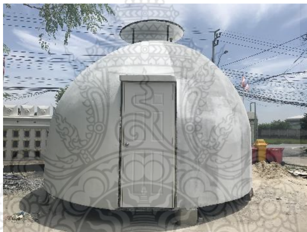
รูปที่ 4.66 ด้านหน้าอาคารสำเร็จรูปครึ่งทรงกลมก่อนทาสี
