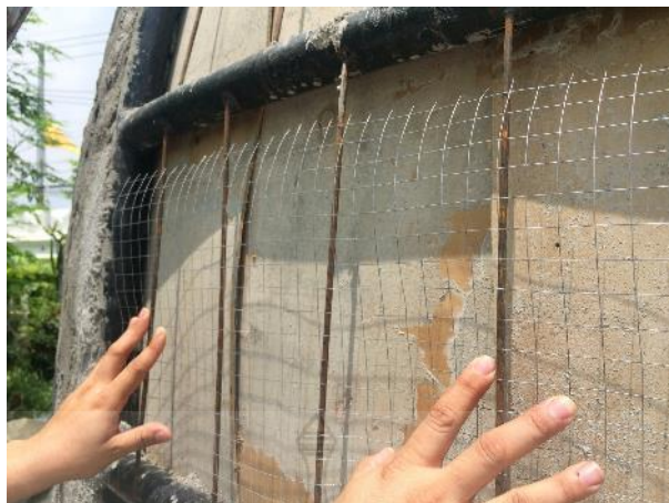
รูปที่ 4.56 แผ่นไม้อัด เหล็กเส้นกลม และเหล็กตะแกรง สำหรับหล่อแผ่นเปลือกอาคาร
