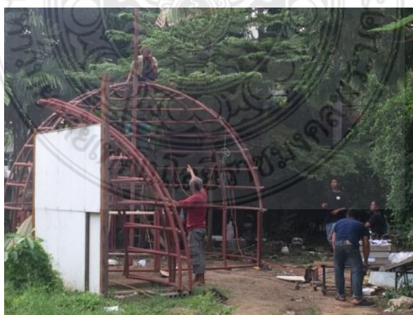
รูปที่ 4.34 โครงสร้างผนังส่วนบนและส่วนล่างที่เชื่อมติดกันแล้ว
