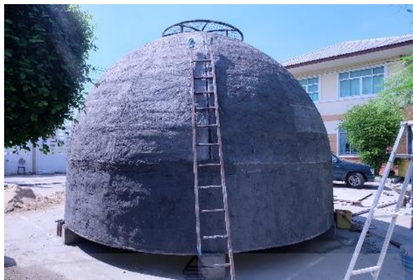
รูปที่ 3.33 ฉาบส่วนผสมในแบบหล่อที่มีการติดตั้งตะแกรงเหล็กไว้
