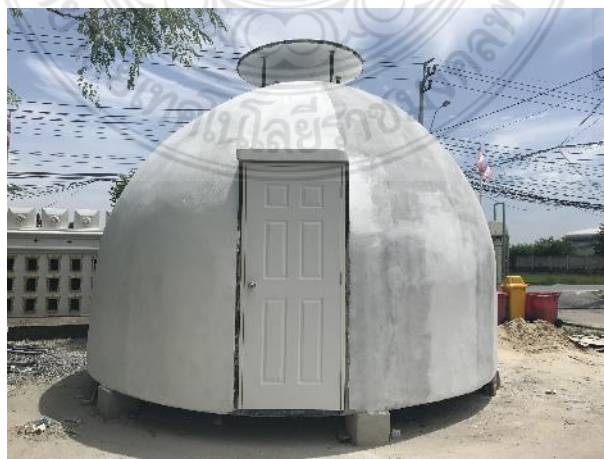
รูปที่ 21 ด้านหน้าอาคารสำเร็จรูปครึ่งทรงกลมก่อนทาสี
