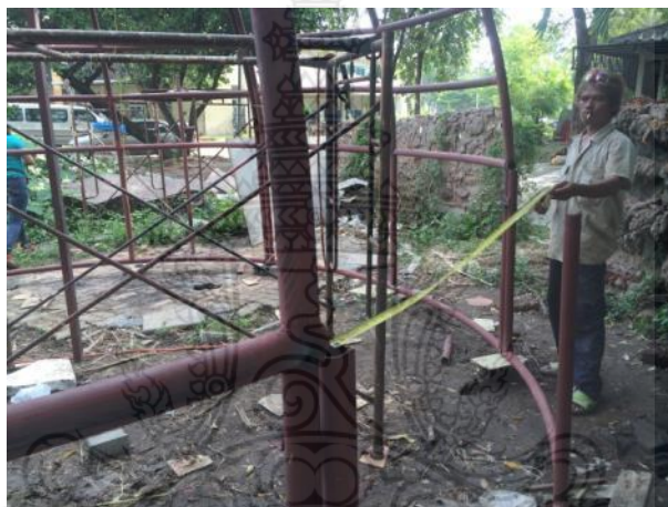
รูปที่ 4.24 การวัดขนาดของโครงสร้างผนังอาคารส่วนล่าง
