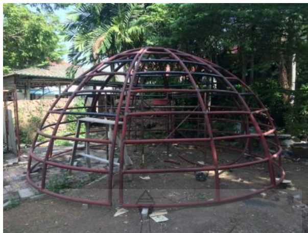
รูปที่ 4.17 โครงสร้างผนังส่วนบนของอาคารสำเร็จรูปทรงครึ่งทรงกลม ทั้ง 6 ส่วน
