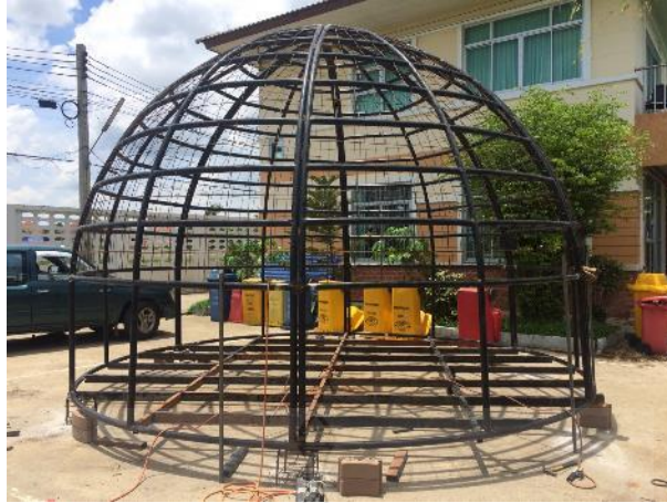
รูปที่ 9 โครงสร้างอาคารสำเร็จรูปที่พร้อมสำหรับการหล่อและฉาบเปลือกอาคาร
