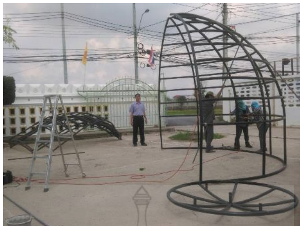
รูปที่ 4.50 การประกอบโครงสร้างอาคารสำเร็จรูปที่แยกชิ้นส่วนมา
