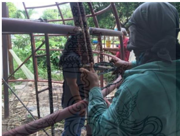
รูปที่ 4.30 การขันชะเนาะเพื่อให้โครงสร้างผนังเข้ารูปได้อย่างสมบูรณ์
