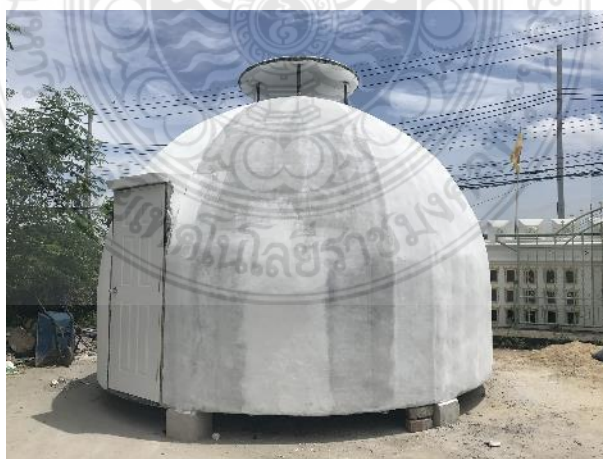
รูปที่ 3.35 เปลือกอาคารที่ผ่านการหล่อและฉาบเรียบแล้ว
