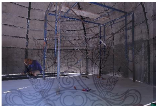
รูปที่ 3.34 การฉาบเรียบเปลือกอาคารให้มีความสวยงามเรียบร้อย
