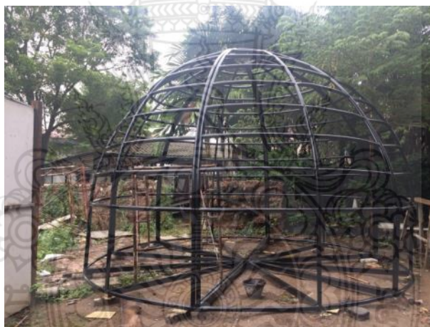
รูปที่ 4.36 โครงสร้างอาคารสำเร็จรูปทรงครึ่งทรงกลมก่อนการเจาะรูเพื่อทำรอยต่อ
