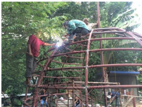
รูปที่ 4.33 การเชื่อมโครงสร้างผนังชั่วคราวเพื่อให้โครงสร้างเข้ารูปอย่างสมบูรณ์
