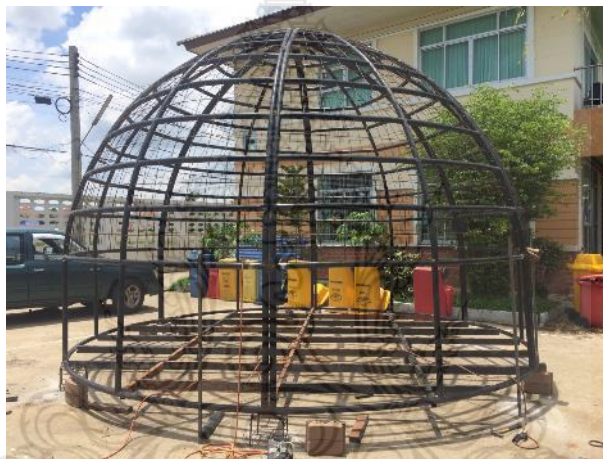
รูปที่ 4.54 โครงสร้างอาคารสำเร็จรูปที่พร้อมสำหรับการขึ้นรูปและติดตั้งเปลือกอาคาร
