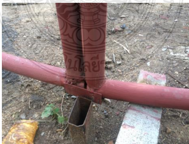
รูปที่ 4.22 การวางรอยต่อส่วนล่างชั่วคราวของโครงสร้างผนัง
