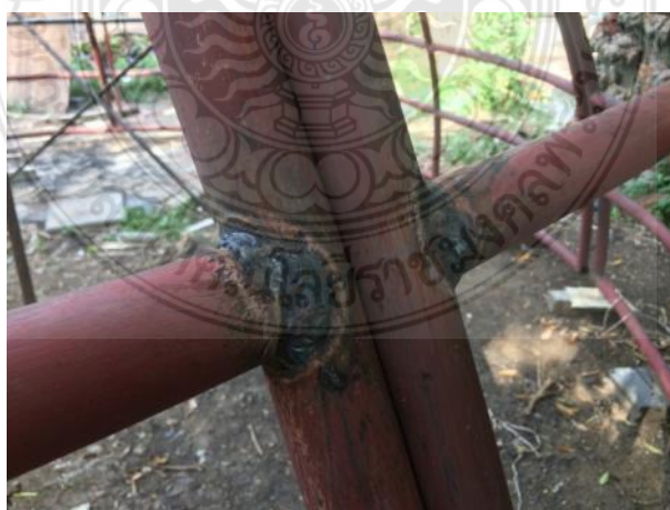
รูปที่ 4.16 การเชื่อมพอกบริเวณรอยต่อของอาคารสำเร็จรูปทรงครึ่งทรงกลม
