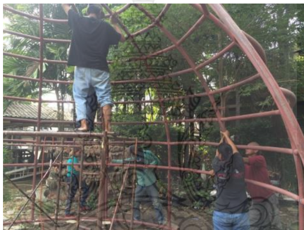
รูปที่ 4.27 การจัดโครงสร้างผนังส่วนบนให้เข้ารูป
