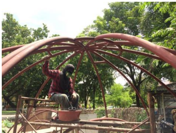
รูปที่ 4.14 การติดตั้งโครงสร้างผนังแนวนอนส่วนบนสุดของอาคารสำเร็จรูปทรงครึ่งทรงกลม
