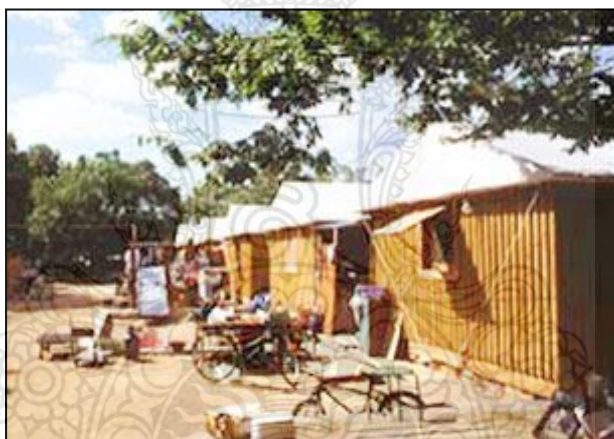
รูปที่ 2.3 อาคารบ้านพักอาศัยชั่วคราว เมืองโกเบ ที่ก่อสร้างด้วยท่อกระดาศ
