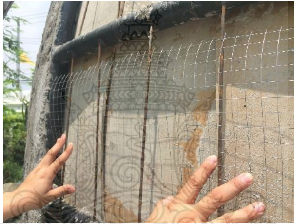
รูปที่ 10 การติดตั้งแผ่นไม้อัด เหล็กเส้นกลม และเหล็กตะแกรง สำหรับหล่อแผ่นเปลือกอาคาร
