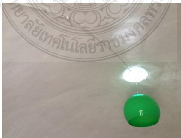
รูปที่ 4.73 การติดตั้งระบบแสงสว่างของอาคารสำเร็จรูปครึ่งทรงกลม
