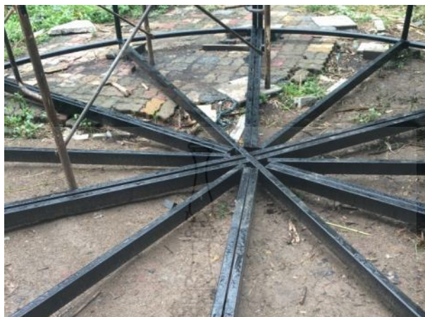
รูปที่ 4.35 โครงสร้างพื้นที่เชื่อมต่อกับโครงสร้างผนังส่วนกลาง
