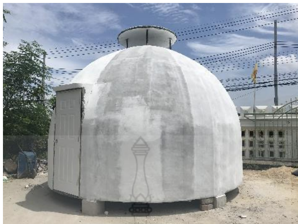
รูปที่ 4.65 ด้านข้างอาคารสำเร็จรูปครึ่งทรงกลมก่อนทาสี
