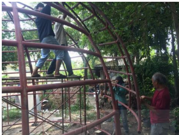
รูปที่ 4.26 การนำโครงสร้างผนังส่วนบนวางบนโครงสร้างผนังส่วนล่าง
