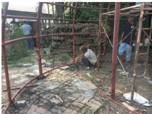
รูปที่ 4.21 การเชื่อมโครงสร้างผนังส่วนล่าง
