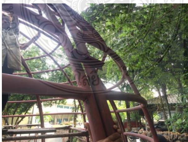
รูปที่ 4.28 การทำสลักชั่วคราวเพื่อช่วยให้โครงสร้างผนังเข้ารูปได้ง่าย
