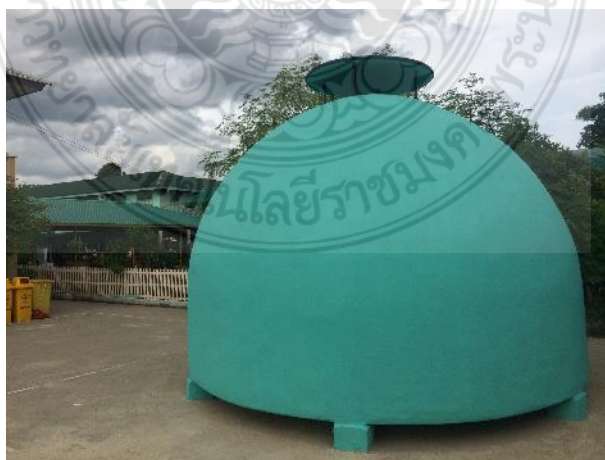
รูปที่ 4.70 ด้านหลังอาคารสำเร็จรูปครึ่งทรงกลมหลังทาสี
