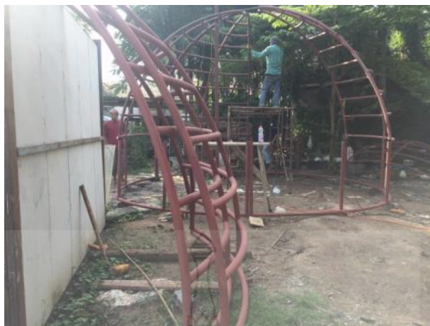
รูปที่ 4.20 การประกอบโครงสร้างผนังส่วนล่างเพื่อรองรับโครงสร้างผนังส่วนบน
