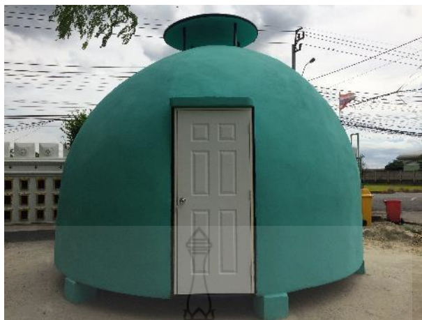
รูปที่ 4.68 ด้านหน้าอาคารสำเร็จรูปครึ่งทรงกลมหลังทาสี
