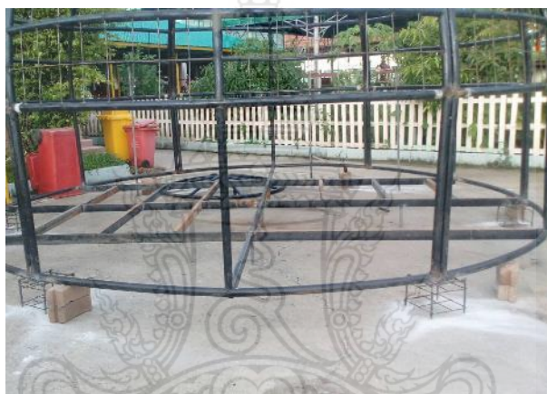
รูปที่ 4.51 การประกอบฐานของโครงสร้างอาคารสำเร็จรูป
