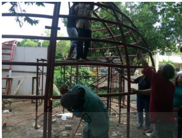
รูปที่ 4.29 การเชื่อมโครงสร้างผนังส่วนบนและส่วนล่างให้ติดกันชั่วคราว
