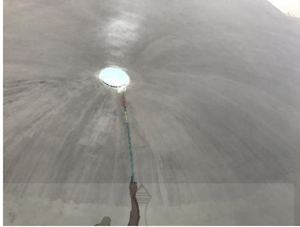
รูปที่ 22 การทำสีผนังอาคารสำเร็จรูปทรงกลม
