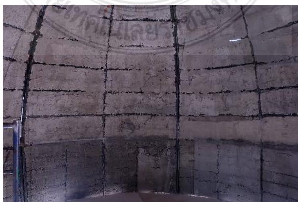
รูปที่ 4.58 ภายในเปลือกอาคารที่มีการฉาบเบื้องต้นไว้แล้ว
