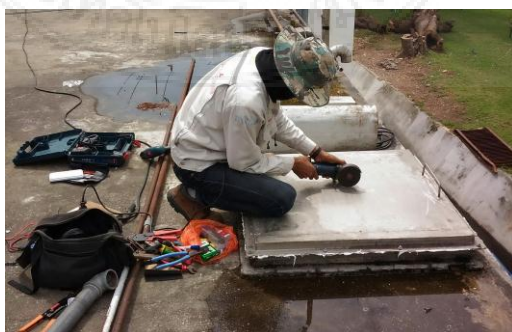
ภาพ 4.3 การเจาะช่องไว้เชื่อมต่ออุปกรณ์ที่ฝาปิดบ่อเล็ก (GT BTG600)
