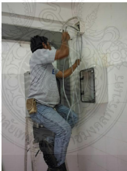
ภาพ 4.7 การต่อสายจากเครื่องวัดระดับปริมาณน้ำมาที่เครื่องรับส่งสัญญาณไร้สายที่อยู่เหนือบ่อ
