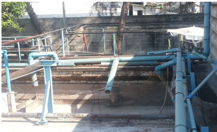
ภาพประกอบที่ 2.14 บ่อเก็บน้ำชั้นแรก (Equalization Tank : EQ)
