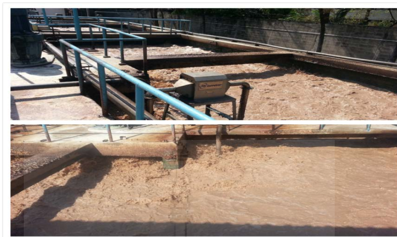
ภาพประกอบที่ 2.17 บ่อเติมอากาศทั้ง 2 บ่อ (A 1 , A 2 )
