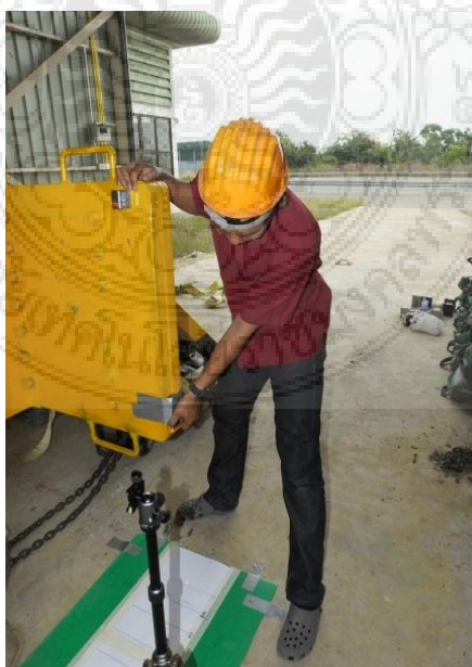
รูปที่ 3.26 การติดตั้งชุดเลเซอร์บอกระยะ
