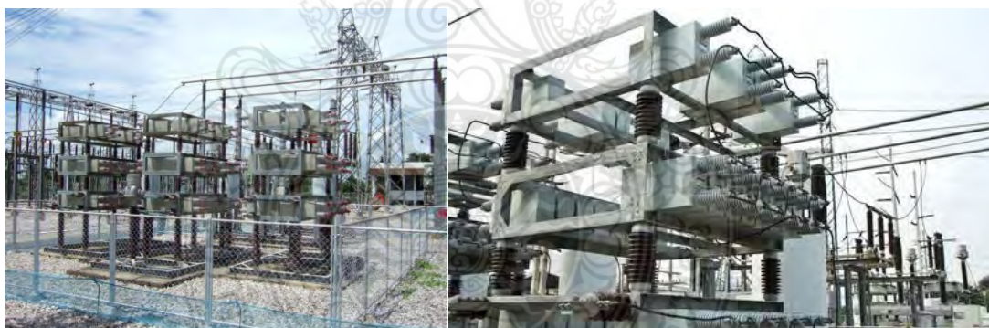
ภาพ 2.9 คาปาซิเตอร์สำหรับระบบไฟฟ้าแรงดันสูง
