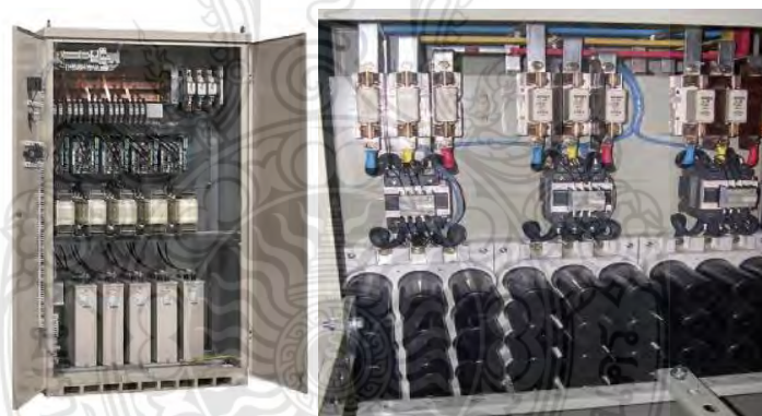
ภาพ 2.7 คาปาซิเตอร์สำหรับระบบไฟฟ้าแรงดันต่ำ
