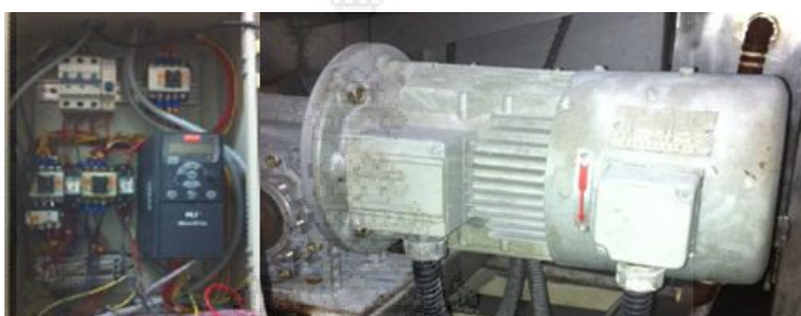
ภาพ 3.12 Inverter ที่ใช้ควบคุมความเร็วมอเตอร์
